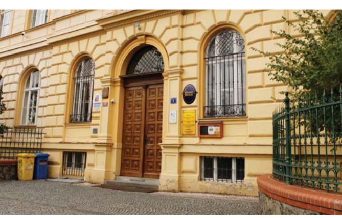
ZŠ Kladská, kde v létě proběhla první část rozsáhlé modernizace.
