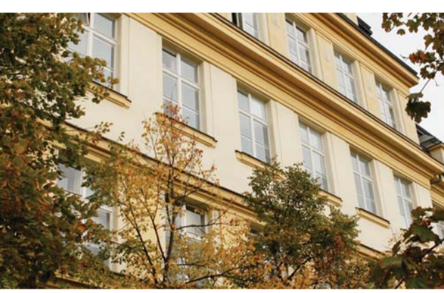
Výměna oken a parapetů v ZŠ Slovenská.
